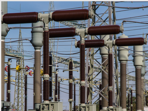
Трансформаторы на трансформаторной подстанции
