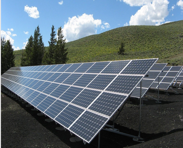
Solarzellen zur Erzeugung elektrischer Energie
